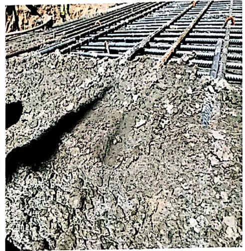
浇筑后混凝土面开裂
