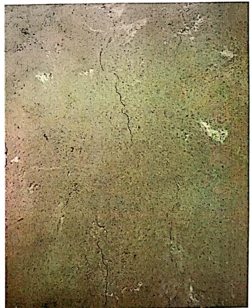
浇筑后混凝土面开裂
