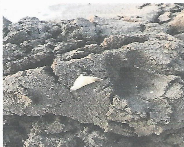
1、成品车棚周边电缆沟抹灰所用砂浆无配合比且存在杂物，现场抹灰的表面存在起砂现象。
