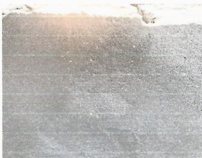
1、成品车棚周边电缆沟抹灰所用砂浆无配合比且存在杂物，现场抹灰的表面存在起砂现象。
