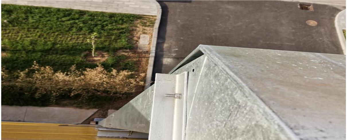
5. 二期 2 号屋面下墙桥架竖向支撑与桥架连接，未起到支撑作用
