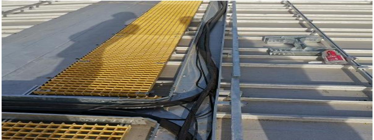
7. 二期 2 号屋面检修通道板之间连接处未按设计进行底部加固
