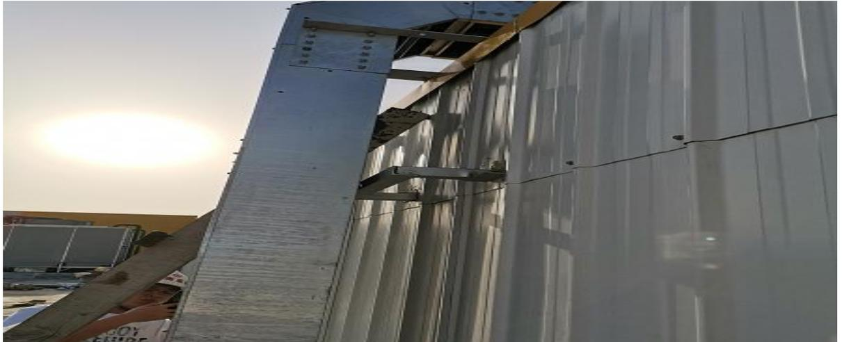
6. 二期 2 号屋面桥架内高压电缆与通信电缆未分开敷设
