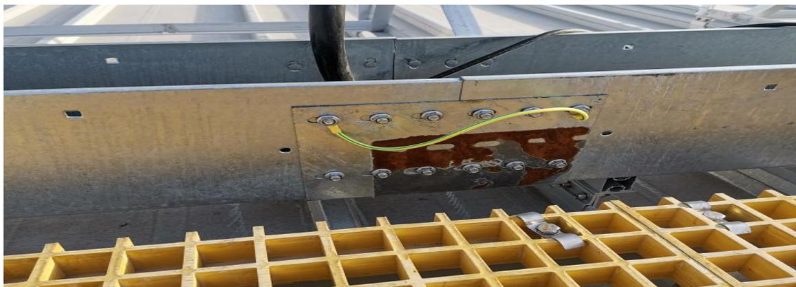
2. 二期 2 号屋面厂房防水涂料太厚导致整排夹具无法扣紧。
