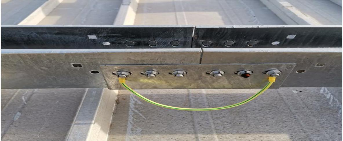
4. 二期 2 号屋面下墙桥架盖板未固定紧需重新固定。
