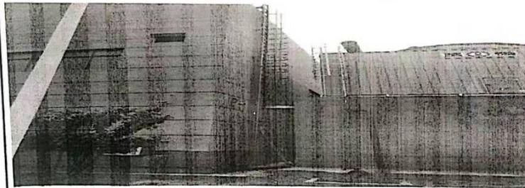
2. 1号厂房底部木制爬梯需更换钢结构爬梯，稳定性，安全性更高。
