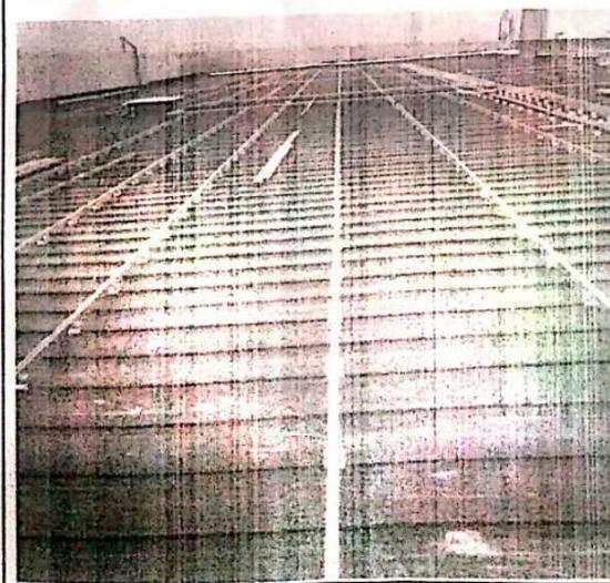
2. 1号屋面天沟里施工垃圾清理不及时，要求立即安排施工人员清理。
