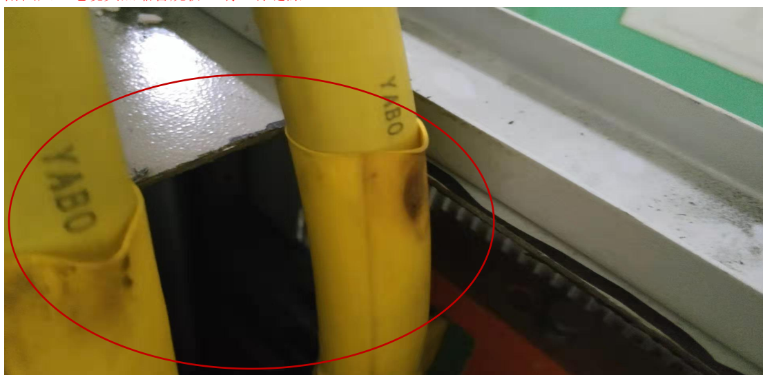
附图九：热缩管未包到位、绝缘层刀口划伤
