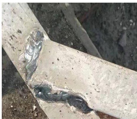
附图五：焊缝不饱满、刷漆不到位
