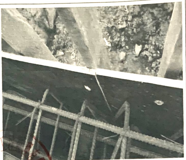
钢筋保护层不符合要求
