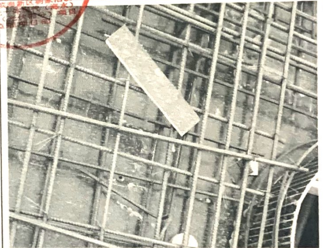
钢筋保护层不符合要求
