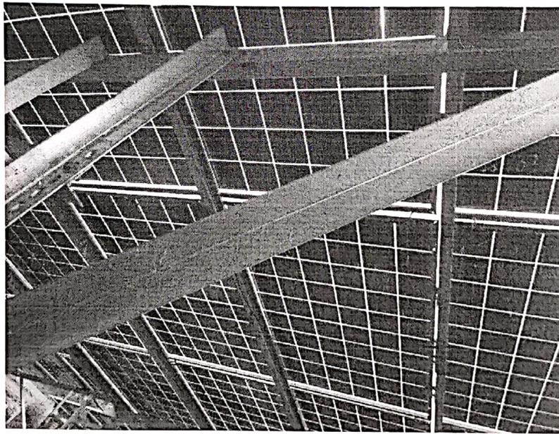
20MW 光伏区支架腐蚀现象已进行了重新打磨、并喷银粉防腐漆
