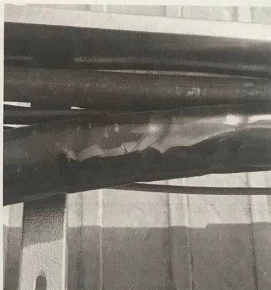
10、桥架内个别交流电缆有划伤需修复处理。
