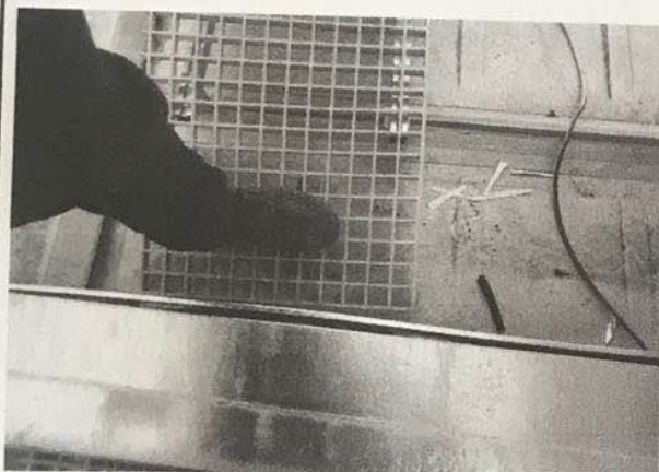
6、视频监控立柱未接地，电缆桥架内视频监控线缆接头不牢靠。
