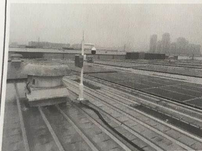
7、个别阵列边侧夹具间距超过 500mm 需增加夹具。 8、个别组件跨接接地线断开失效。
