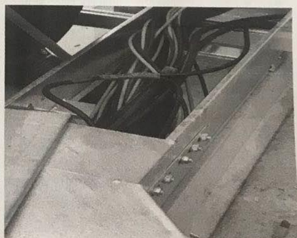
7、个别阵列边侧夹具间距超过 500mm 需增加夹具。 8、个别组件跨接接地线断开失效。
