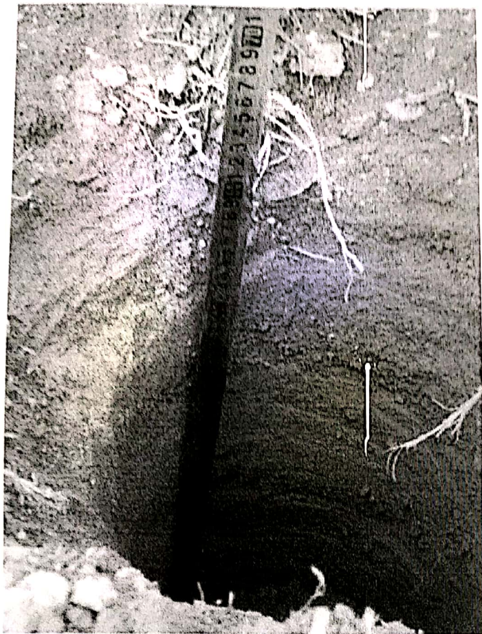
围栏基础基坑清理后深度满足设计要求
