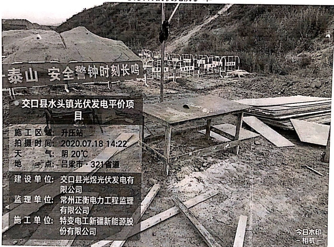
模板切割机无防护罩
