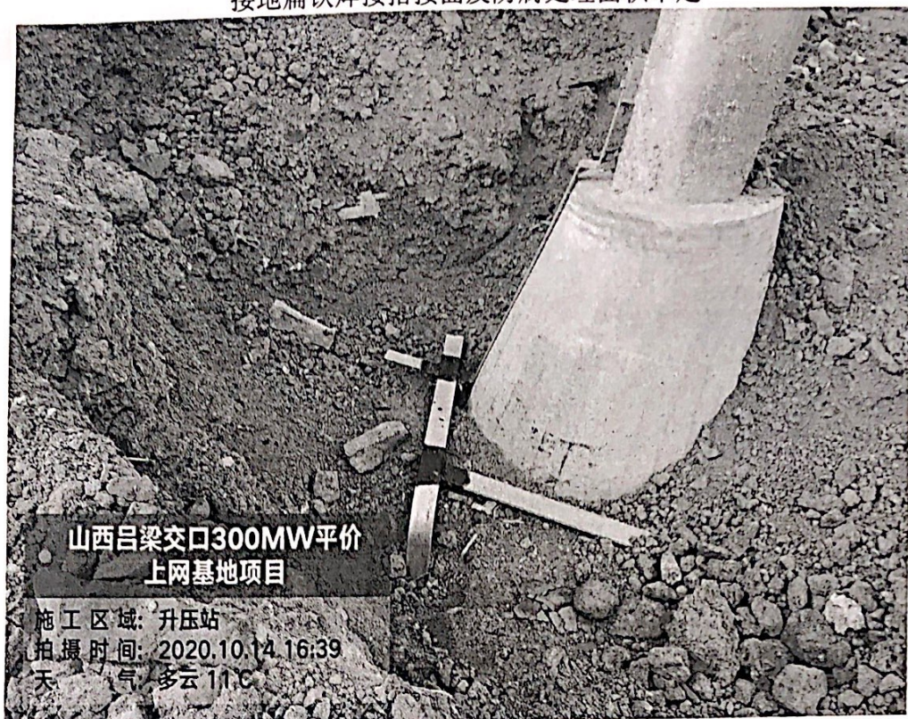
接地扁铁焊接搭接面及防腐处理面积不足
