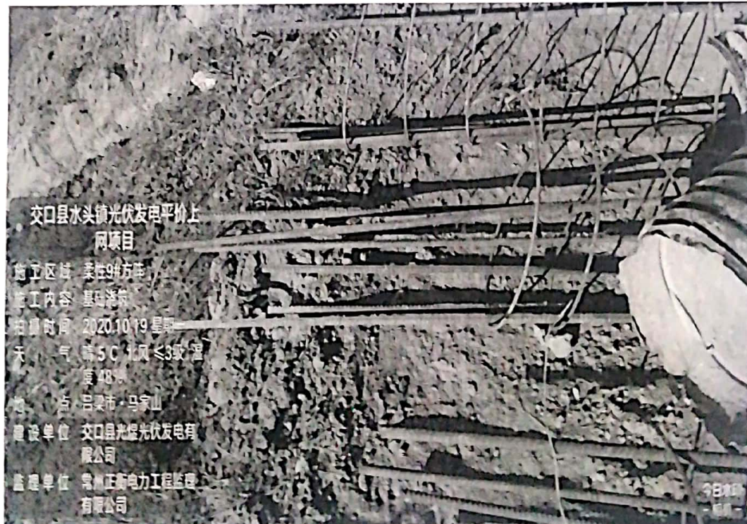
钢筋笼不符合图纸设计要求
