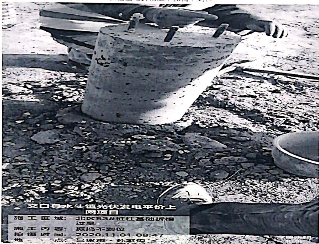
桩柱基础养护不到位
