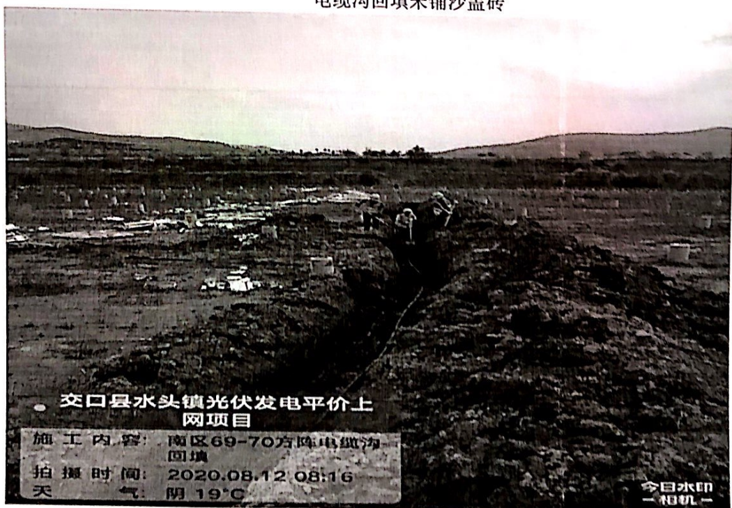
电缆沟回填未铺沙盖砖
