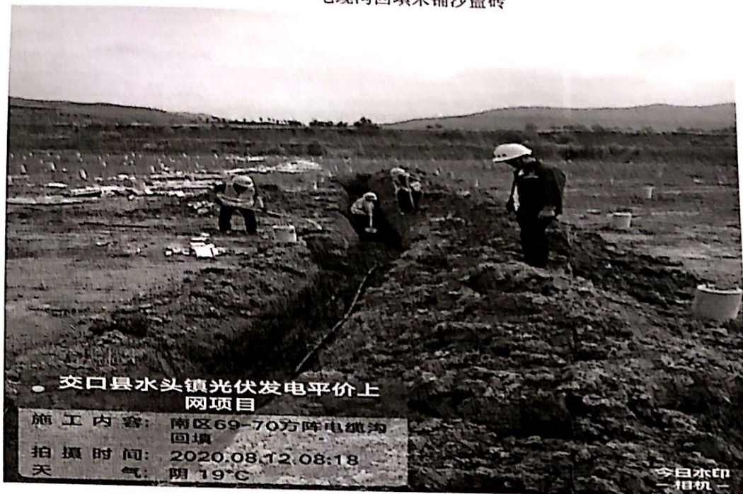
电缆沟回填未铺沙盖砖
