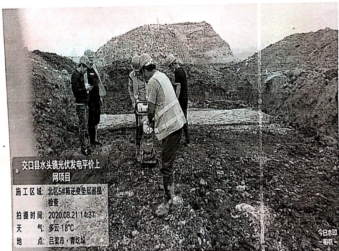
5#箱逆变基础施工未完成进行报验
