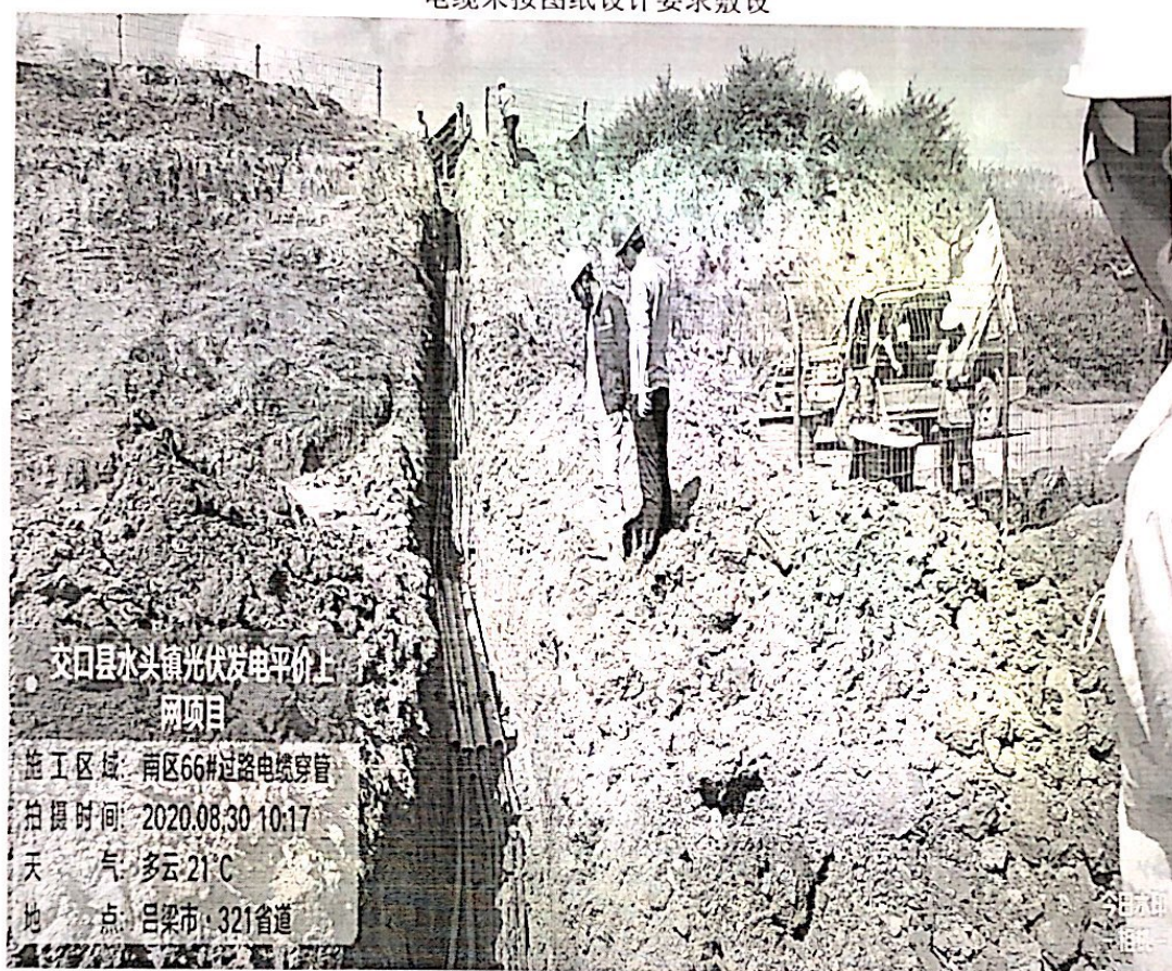
电缆未按图纸设计要求敷设
