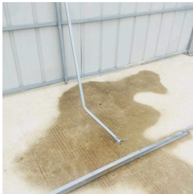
东侧围挡斜撑底脚断
