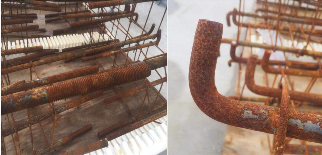
现要求你部对三区地脚螺栓完成除锈防锈及成品保护相关的整改工作。未采取保护措施或处理不当的而使用的，将根据根据浙江慈农电力发展有限公司项目部《施工项目部考核细则》相关条款给予相应考核，拒不整改的将要求你部停工。
