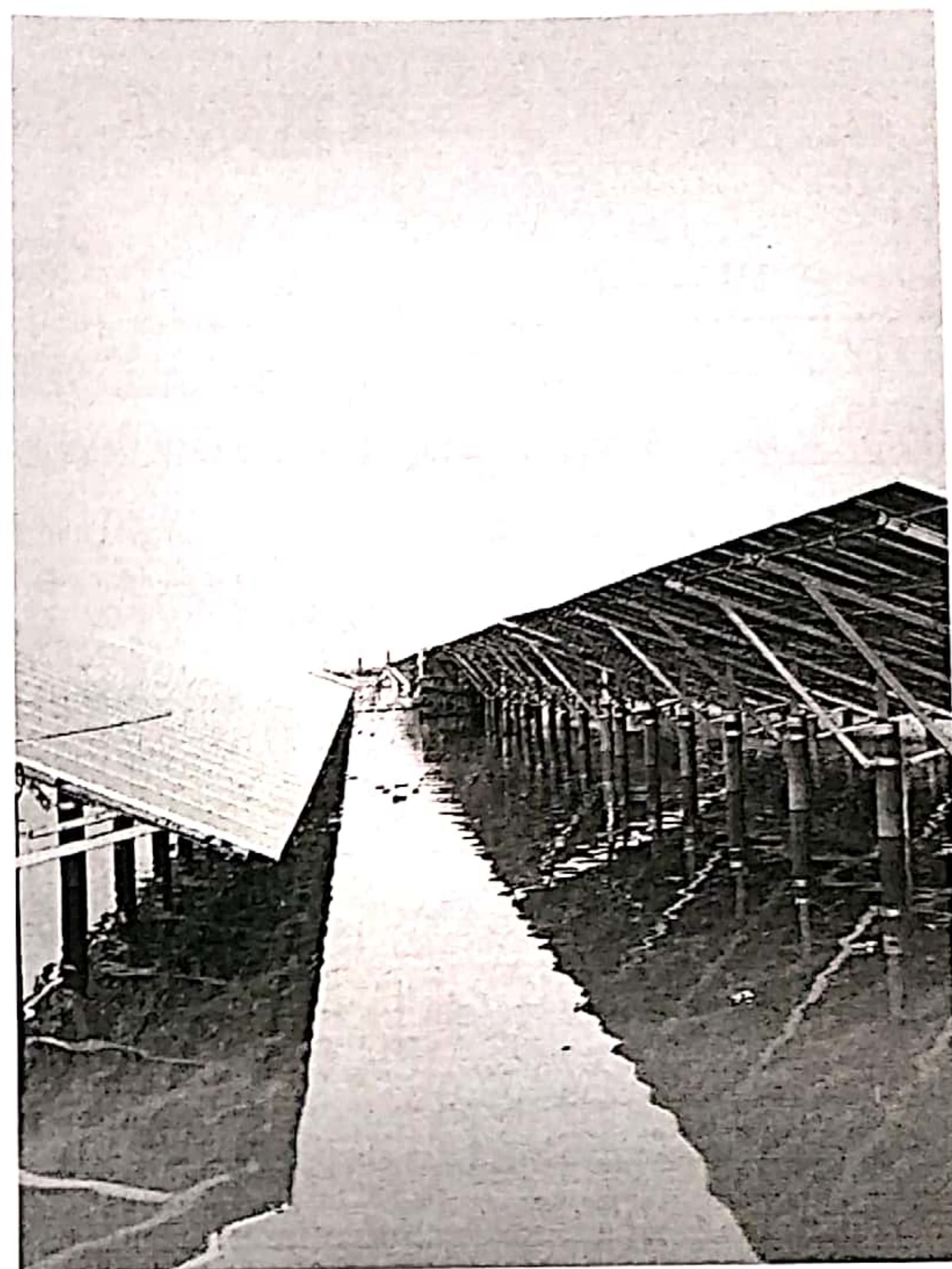
现场整改照片
