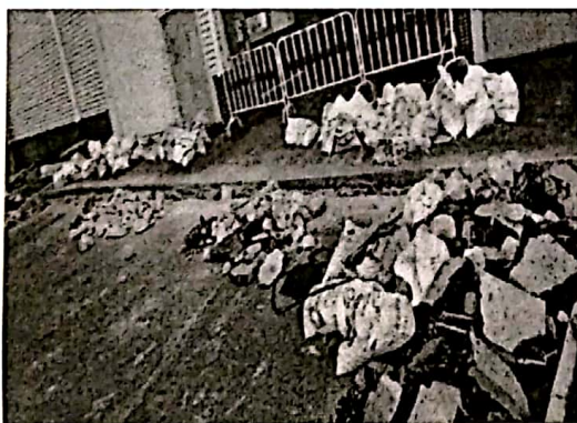
主路破路后垃圾未清理，钢盖板未盖到位，造成主路一直未通车。
