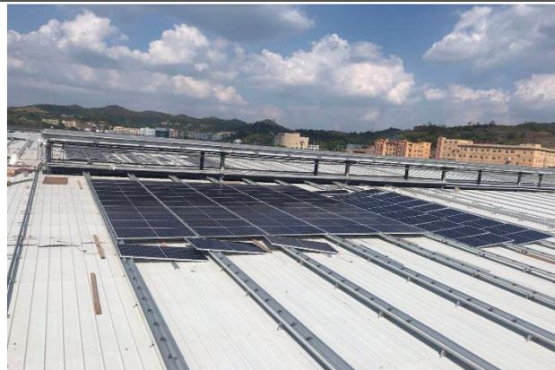
5、女儿墙较低的部位、采光带、未施工区域未进行围护警示。
