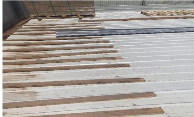
2、富日轴承新建厂房未搭设吊装平台，组件拆箱后未固定。
