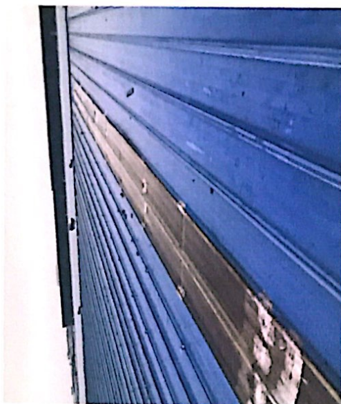
图1 采光带无任何防护防坠措施
