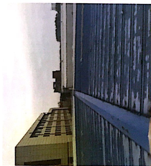
图3 临边维护及现场无任何安全标示、标语
