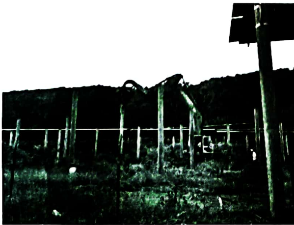
5、打桩人员已进行安全再教育，带电施工区域打桩已安排专人监护；
