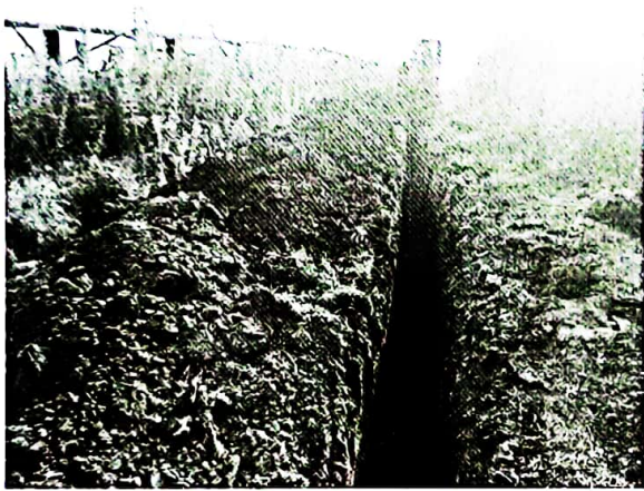
3、已按规范深度开挖电缆沟；
