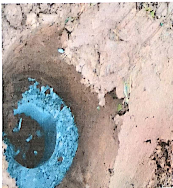
相片三：4.5 米预制管桩拔断
