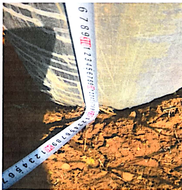
相片四：4.5 米桩入土深度不符合设计要求
