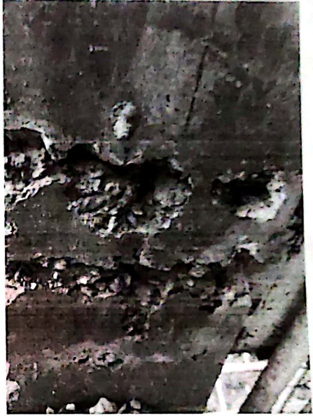
升压站电气楼拆模后的问题相片
