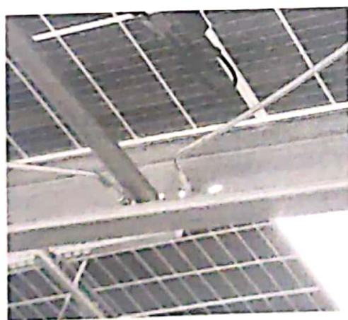
问题五：斜拉条缺少平垫、弹垫、螺母（安装错误）
