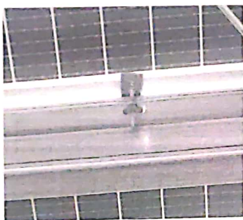
问题三：拉条未紧固且缺少平垫、弹垫
