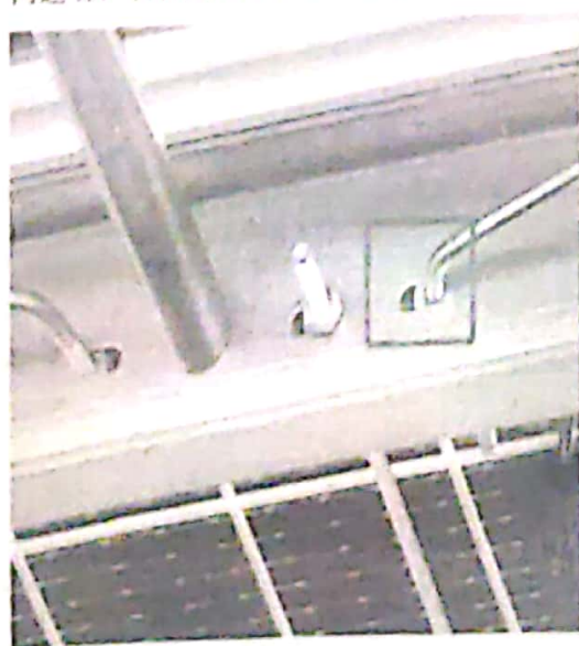
问题五：斜拉条缺少平垫、弹垫、螺母（安装错误）
