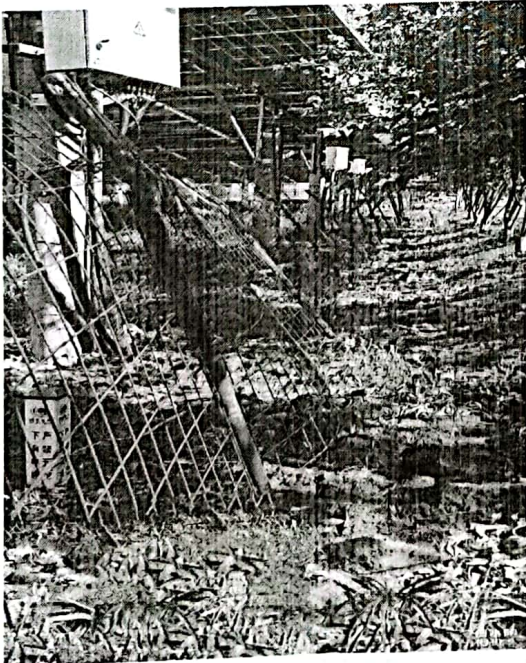
相片三：围栏基础下沉导致围栏倾斜
