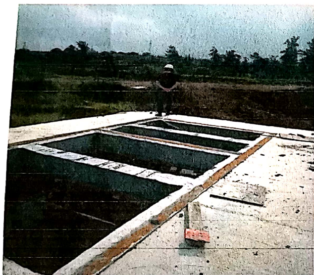
A03 等箱逆变已完工需养护
