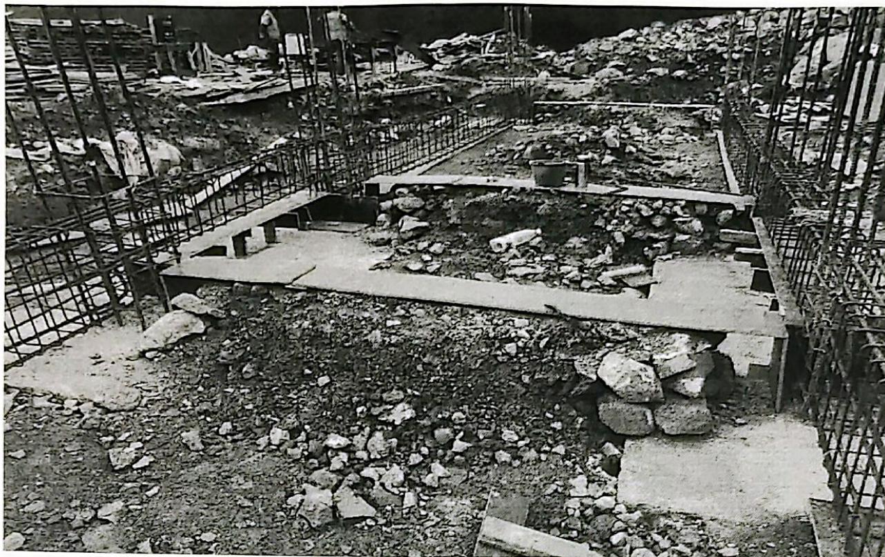
升压站综合楼地梁地模
