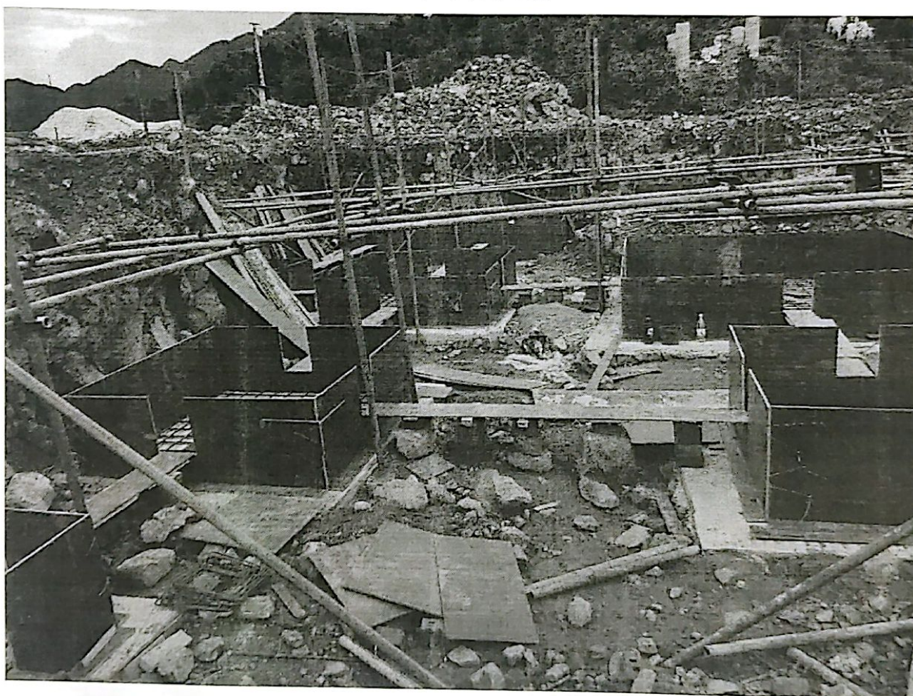
配电楼基础支模
