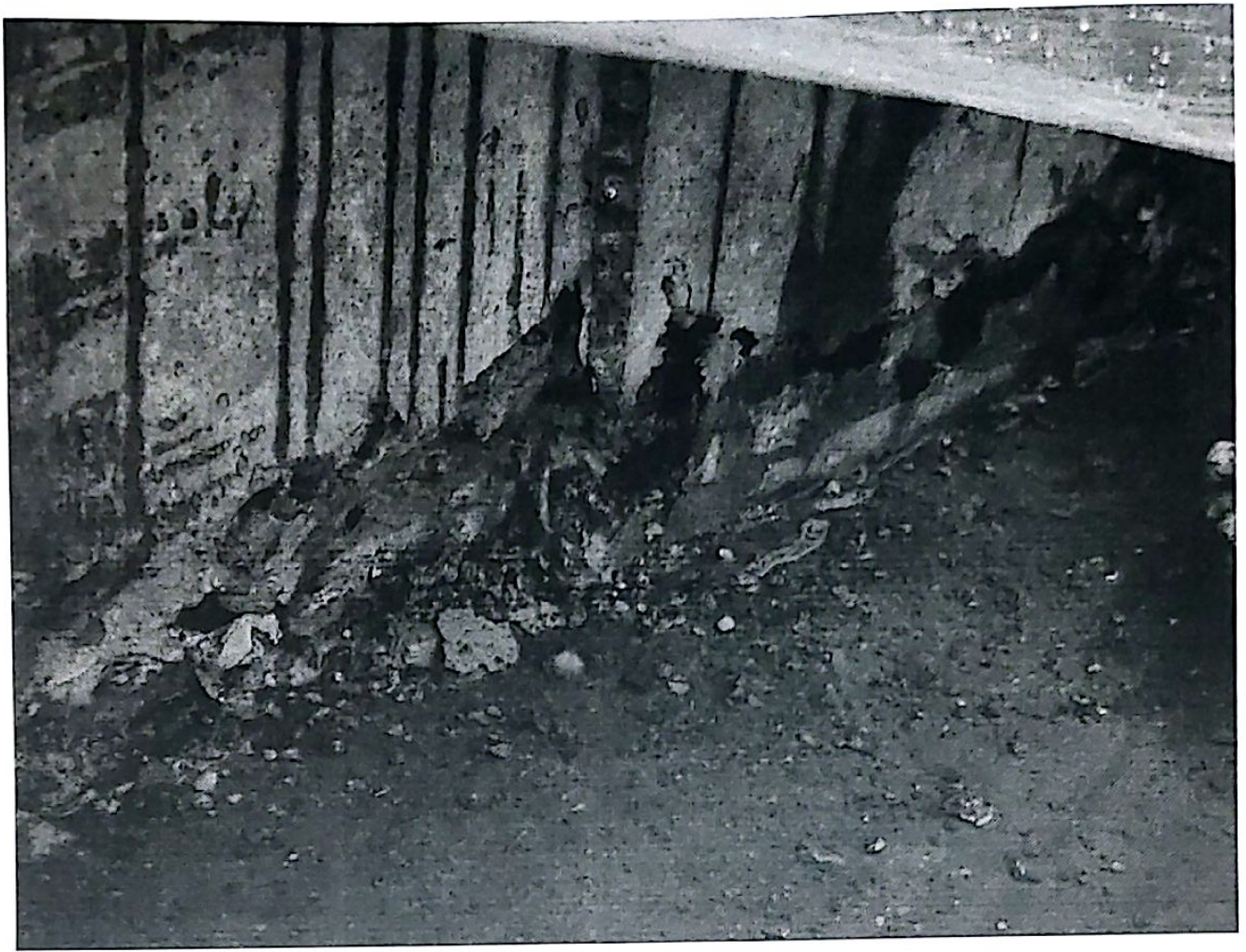
7#风机基础拆模后
