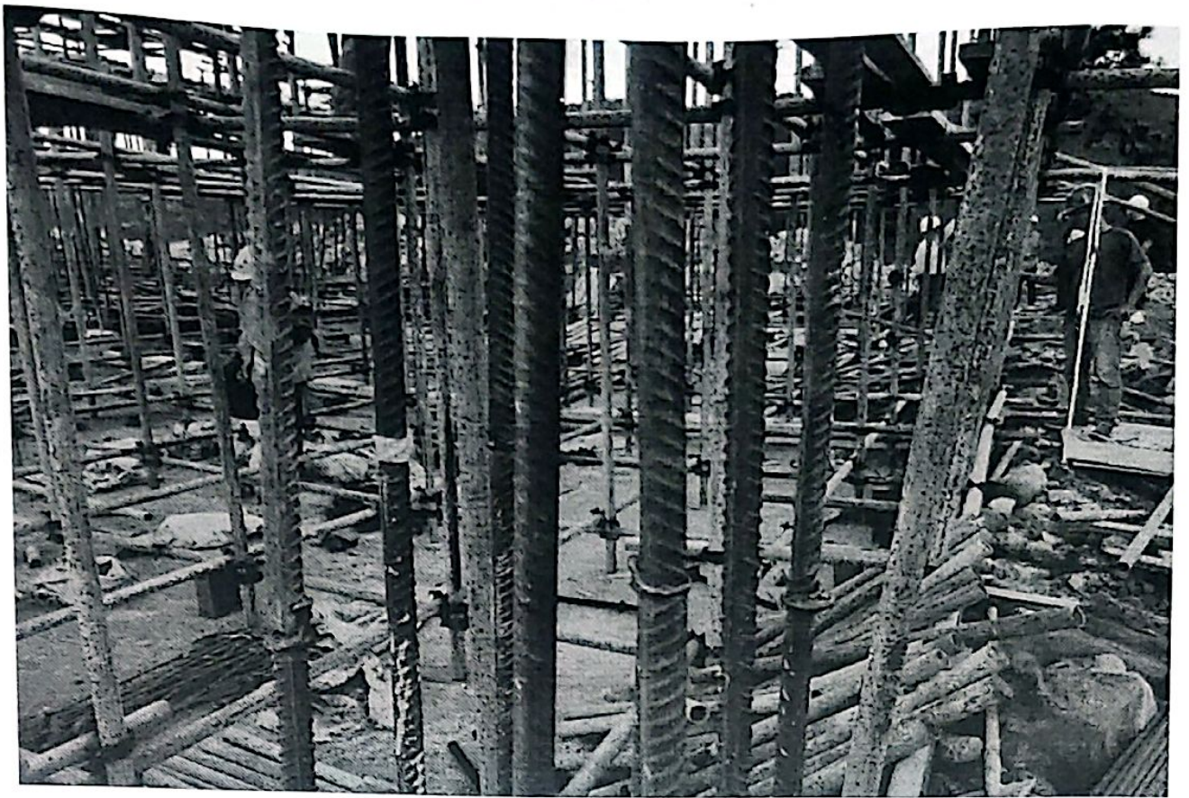
升压站综合楼框架柱
