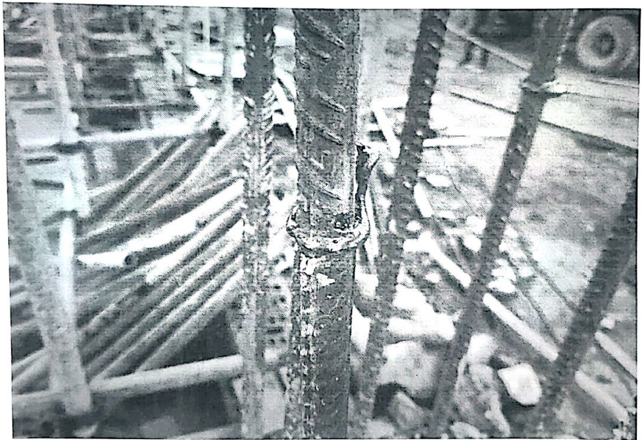
升压站综合楼框架柱
