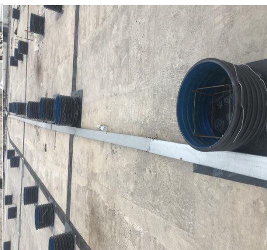
图 6 支架基础与厂区原有桥架贴近
