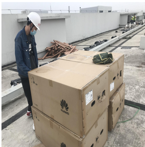
图 5 设备无任何保护措施
