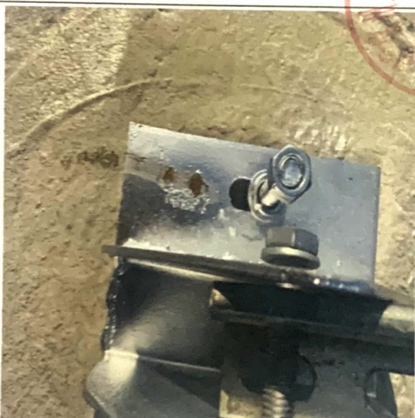
对中后立柱使用自喷镀锌漆
