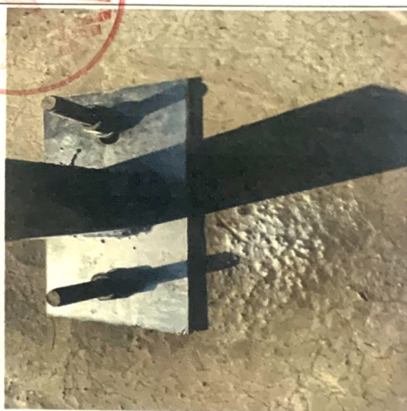
对中后立柱使用自喷镀锌漆
