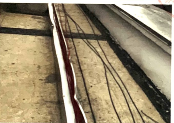
桥架扭曲变形、做好现场成品保护
