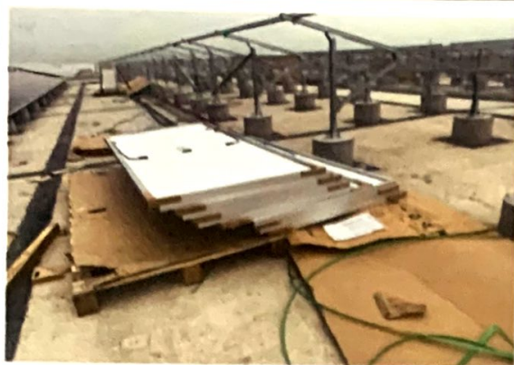
组件倒塌、要求做组件成品保护
