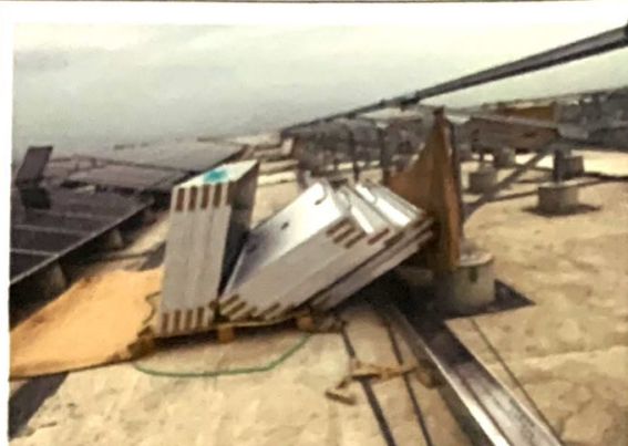
组件倒塌、要求做组件成品保护
