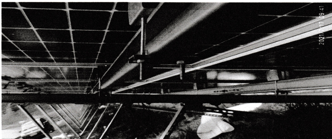
檩托螺栓安装为单帽，与设计图纸双帽不符
