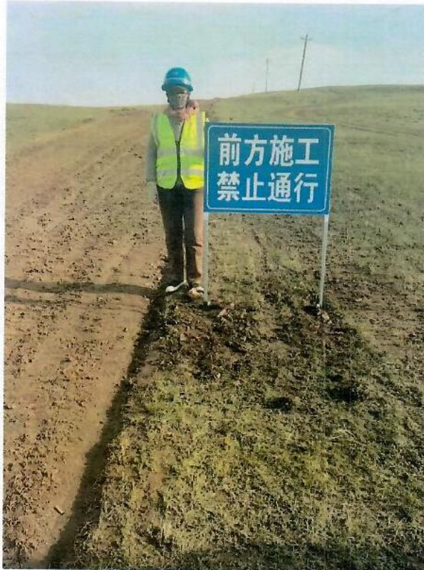
机位道路施工已设置安全警示标牌
