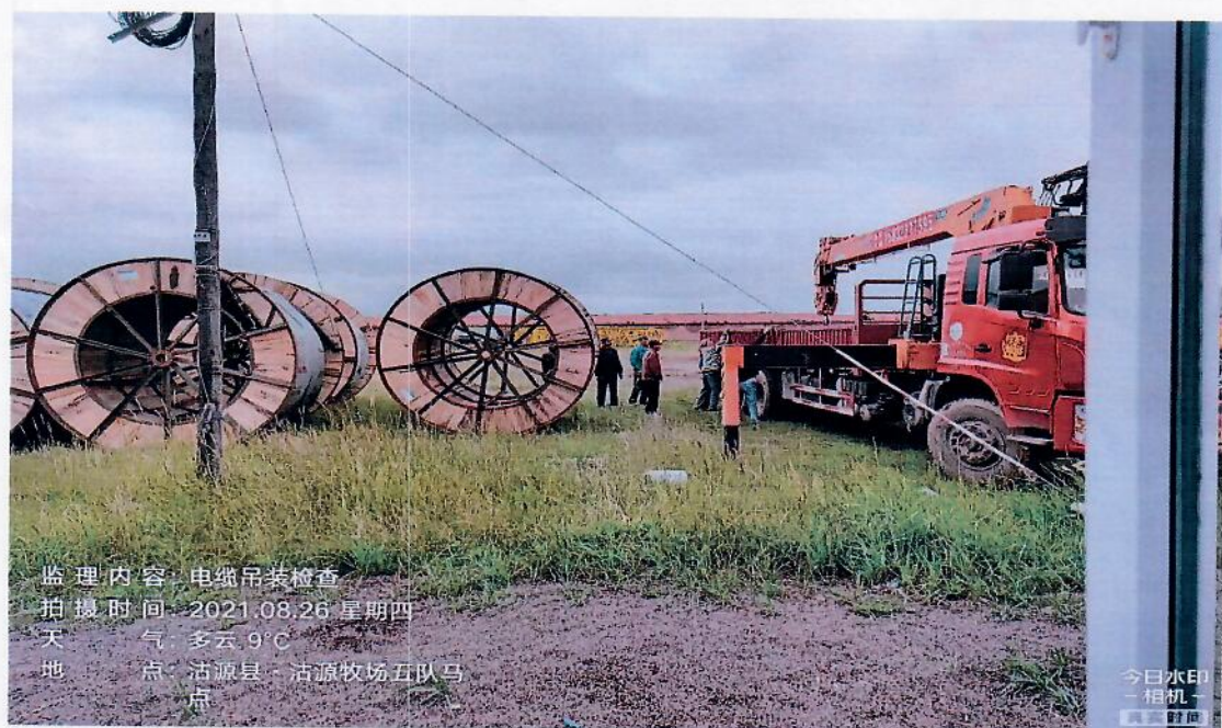
吊装没有设置警戒线和警示标志
