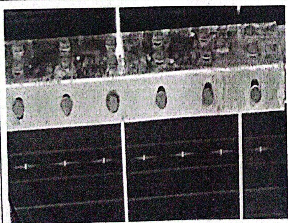
檩条连接件螺栓缺少平垫
