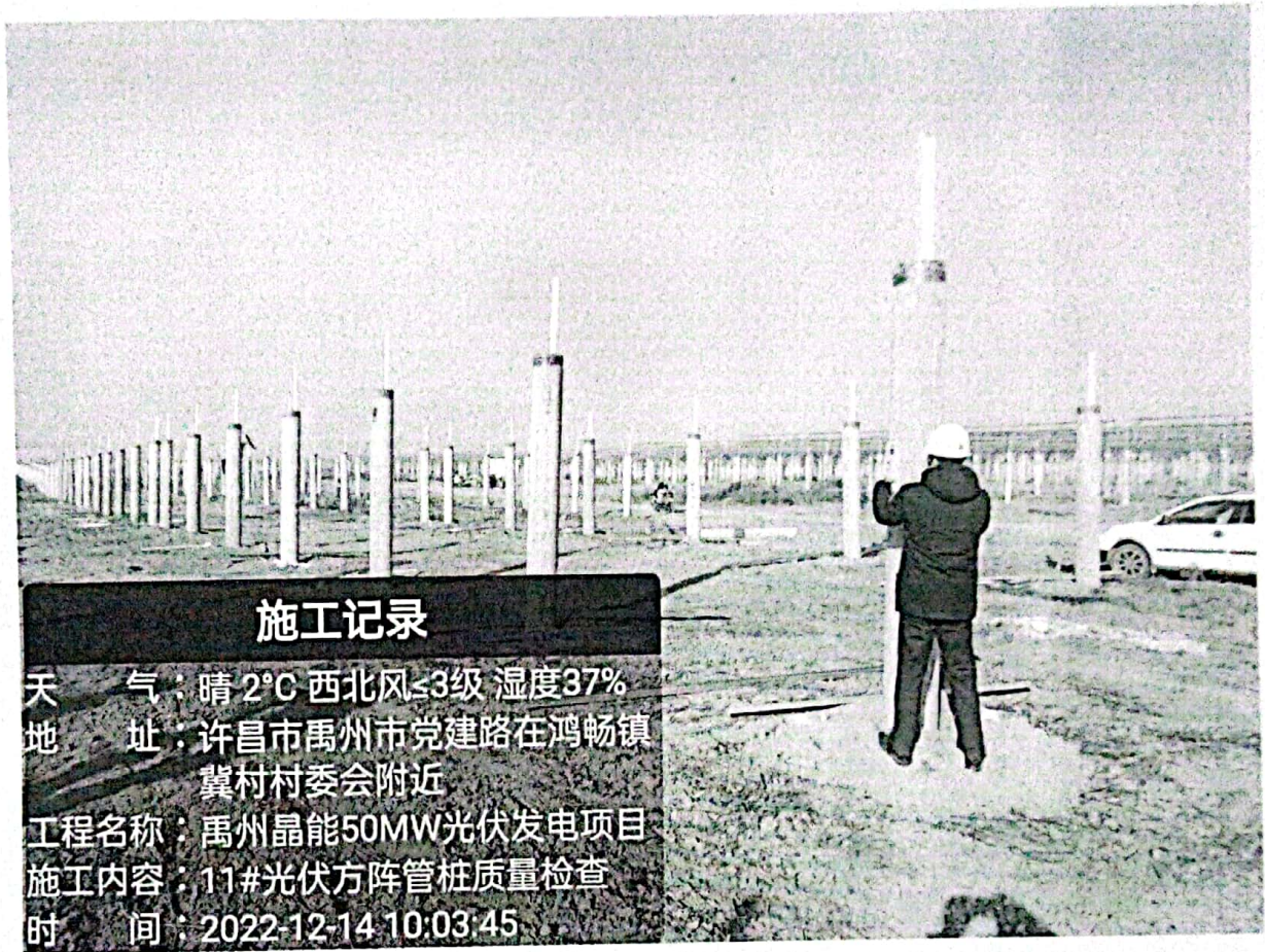
11#光伏方阵管桩垂直度测量
