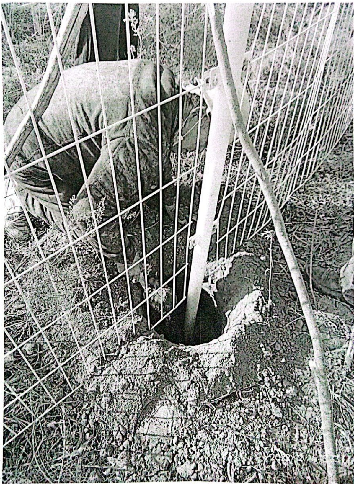
清理围栏基础底部虚土
