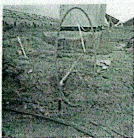
箱逆变设备处接地铺设不符合要求
