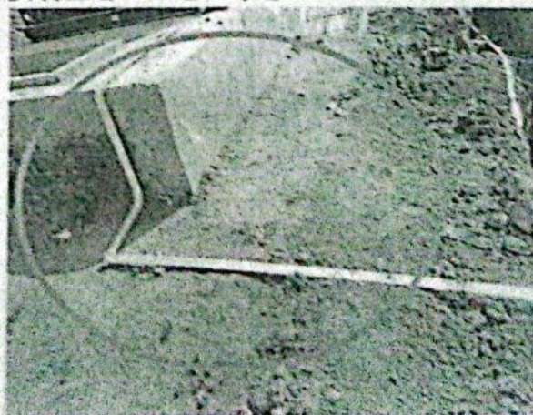
箱逆变设备处接地铺设不符合要求
