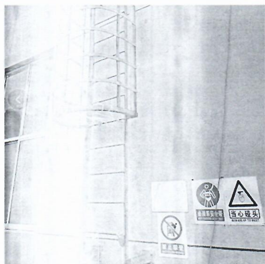
10、上下爬梯未启用，拉警示线，贴警示标识，上下爬梯安装防坠器
