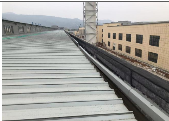
3、采光房临边无安全防护和警示标识
