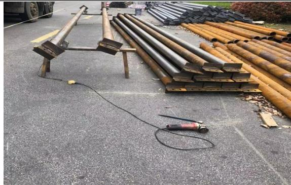
9、外壳未接地（含所用焊机用电设备）
