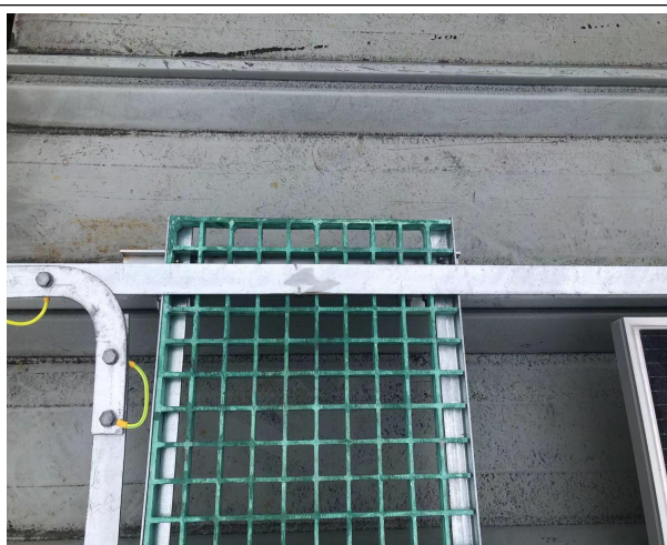
防雷接地用木枋固定
