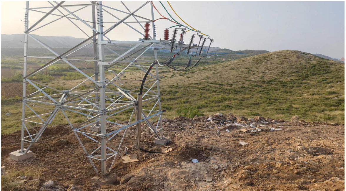
保护管底部电缆没有进行保护
