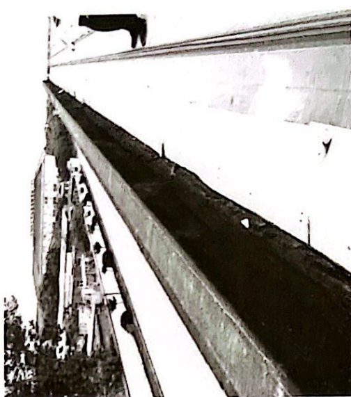
图1 施工区域未见任何安全警示、提醒标示标语无临边维护
