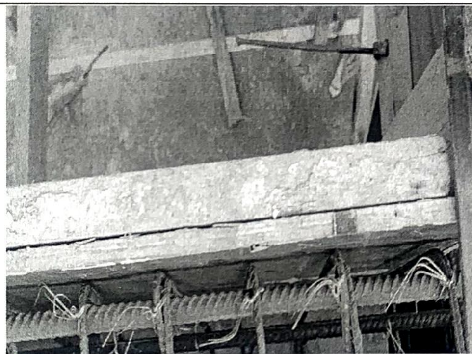
钢筋保护层未达到设计要求
